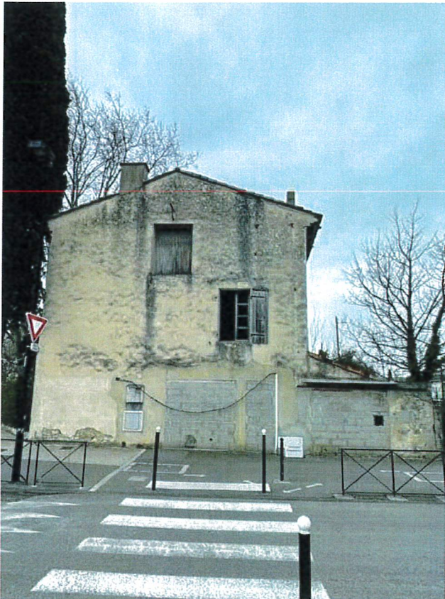
Façade Est coté Avenue des étudiants :
