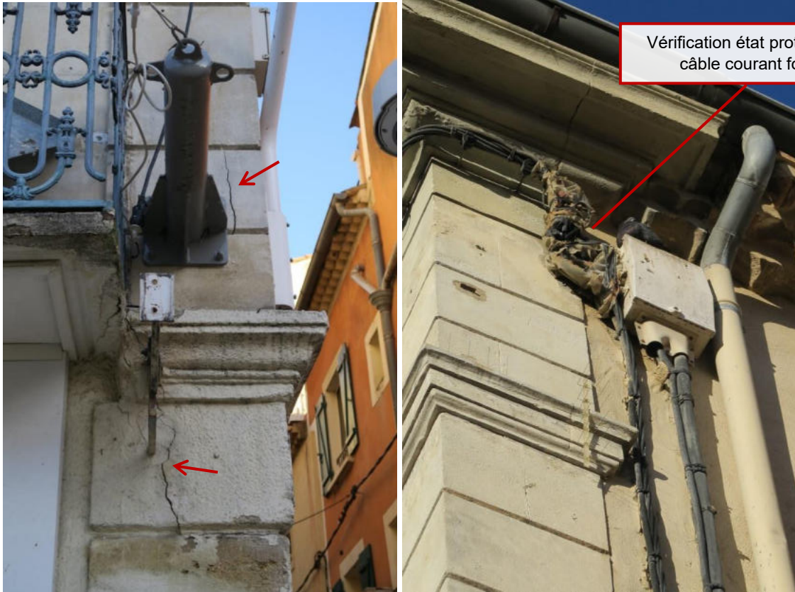
Vue façade depuis rue Saint-Martin
