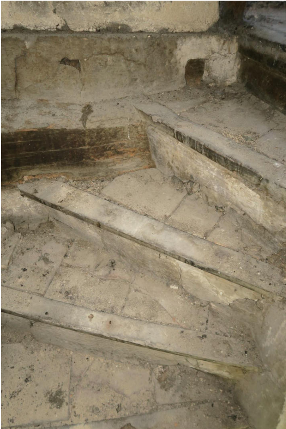
Vue escalier accès R+3
