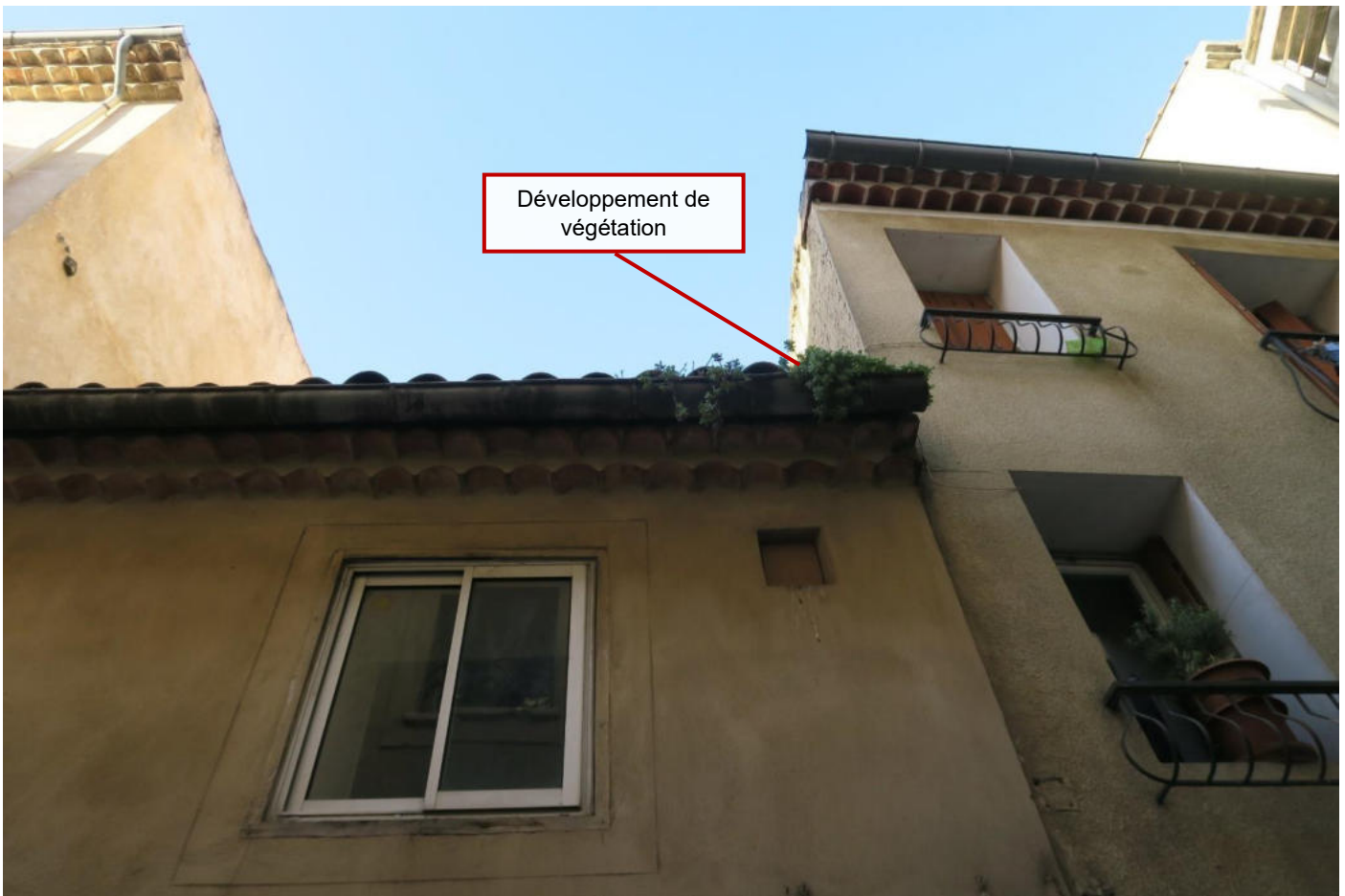
Vue façade depuis rue Gonzague Millet
