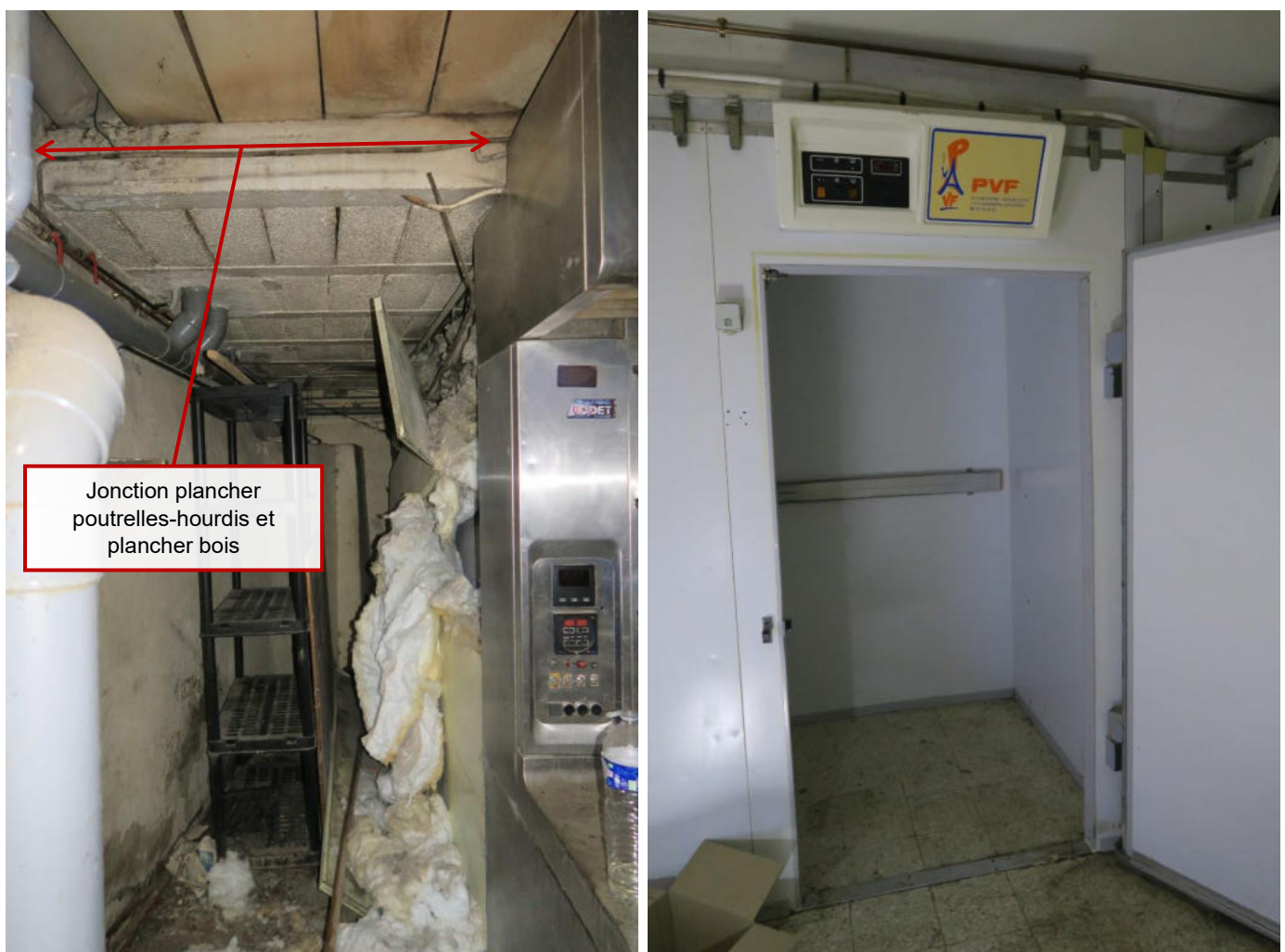
Vues locaux RDC
