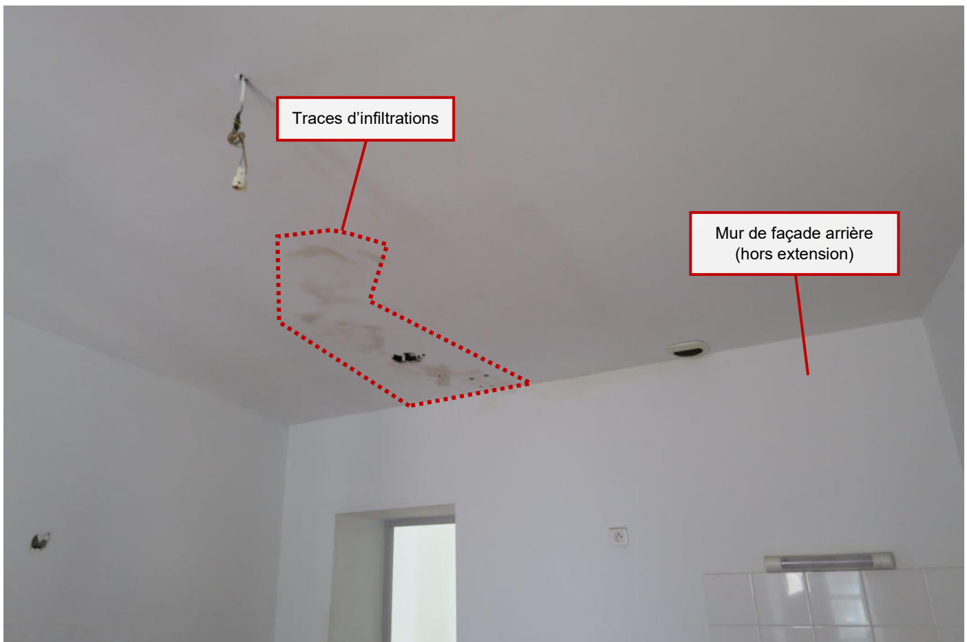
Vue plafond logement Est premier étage
