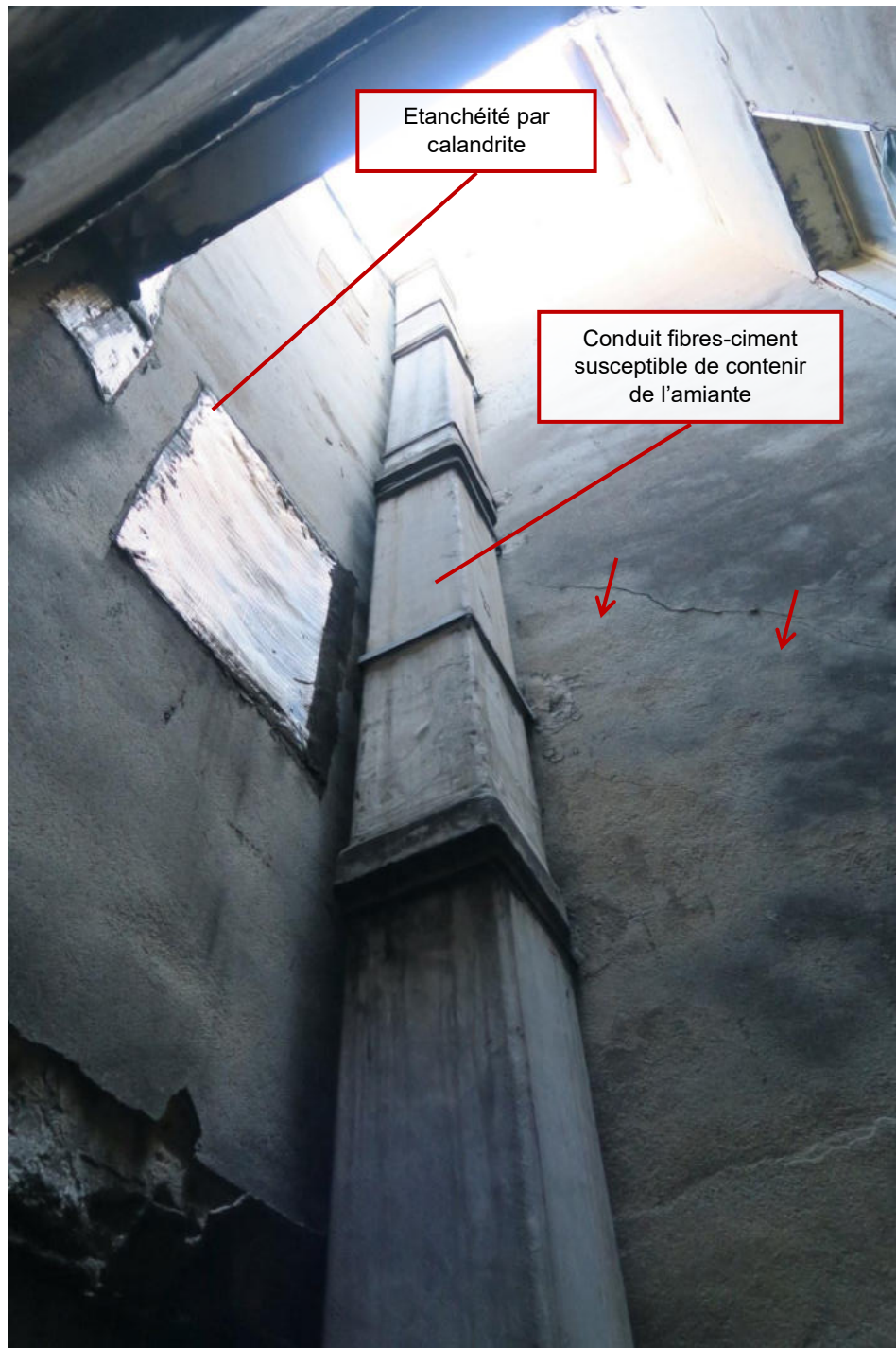
Vue cour intérieure depuis sanitaire R+1
