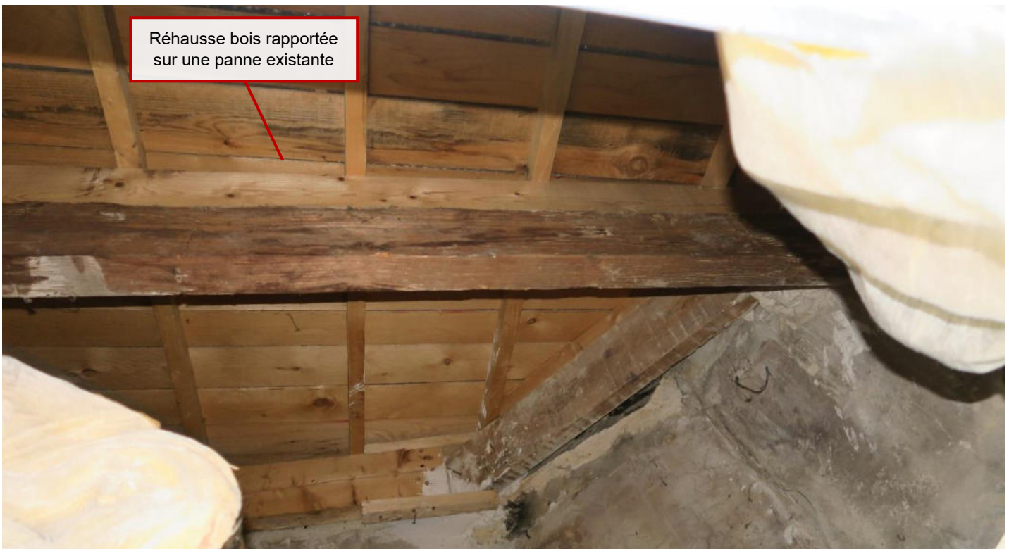
Vue charpente plénum logement premier étage
