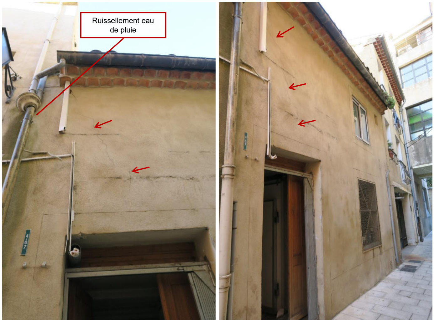
Vues façade depuis rue Gonzague Millet
