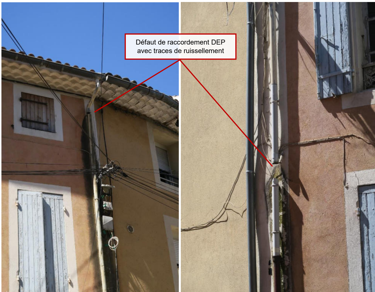
Vues tuyaux de descente EP aux mitoyennetés
