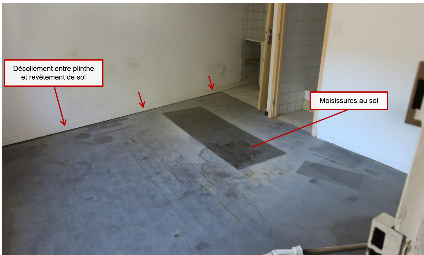
Vue pièce à vivre logement Est R+2
