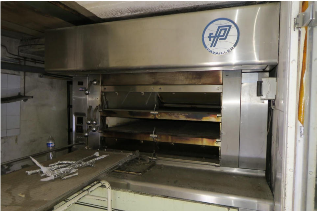
Vues locaux RDC four boulangerie
