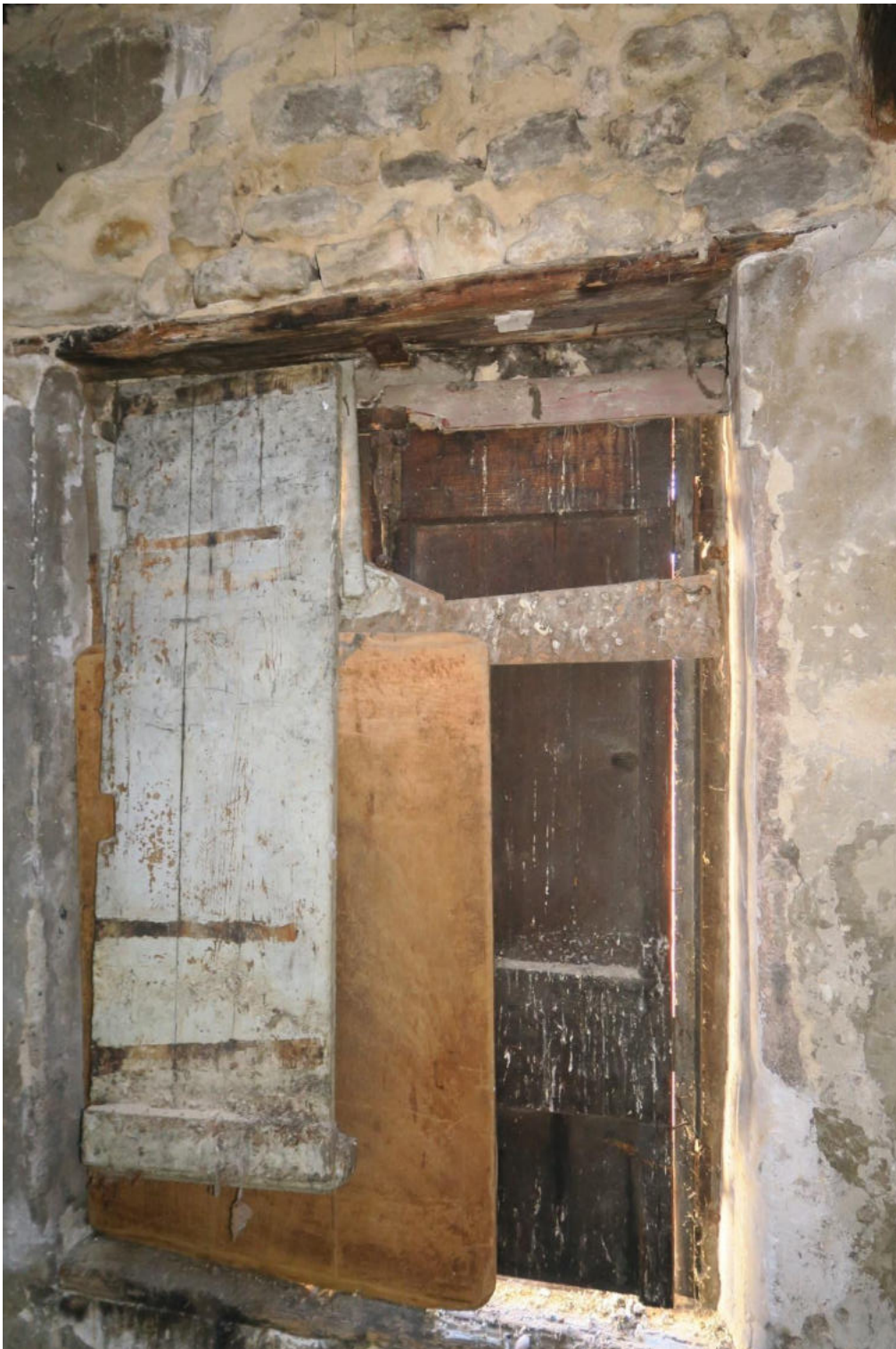
Vue baie R+3 combles façade sur rue Saint-martin
