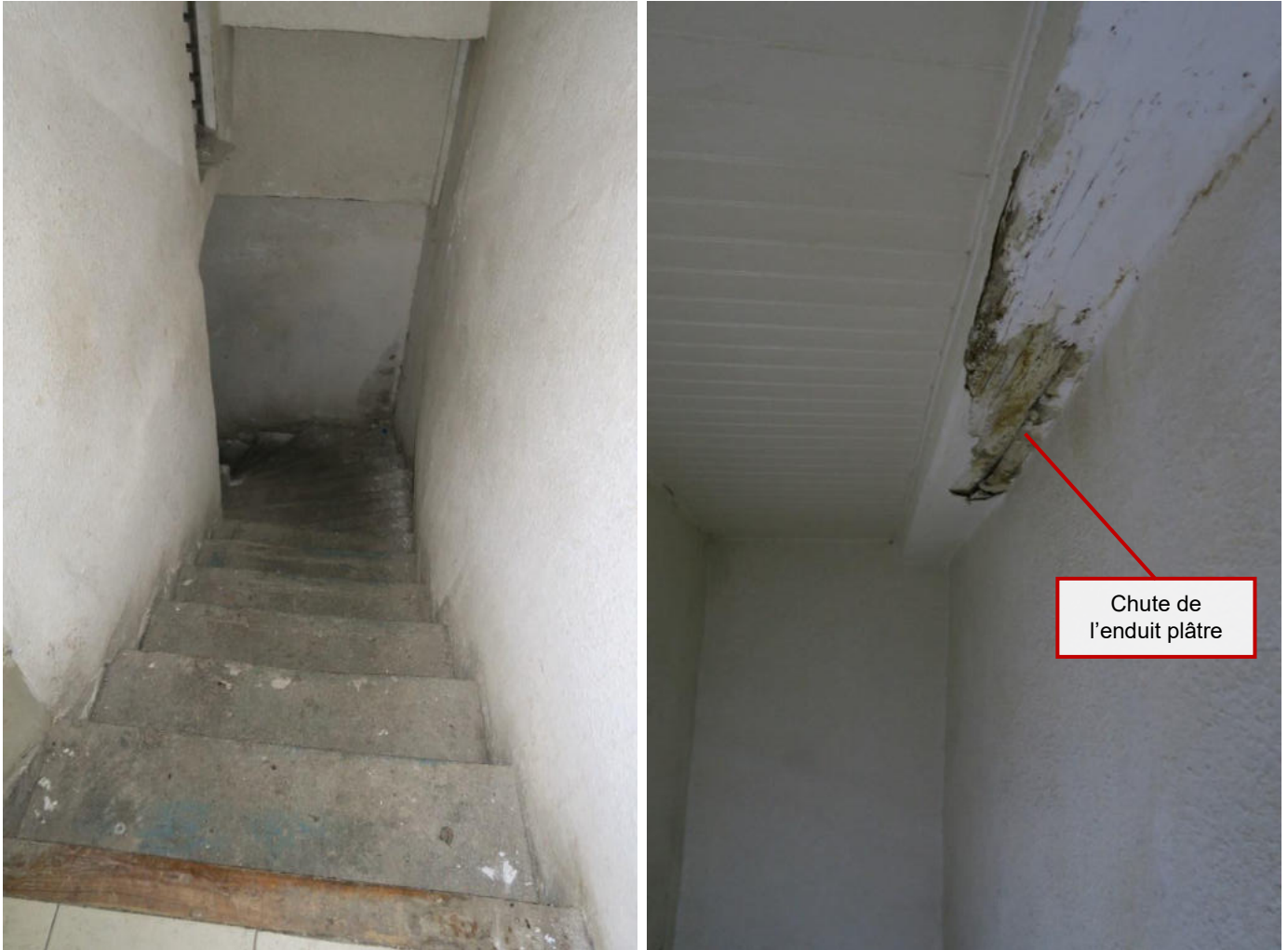
Vues escalier d'accès R+1
