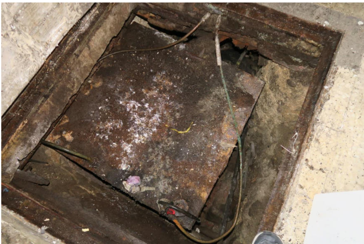
Vues trappe accès cuve à fioul local RDC
