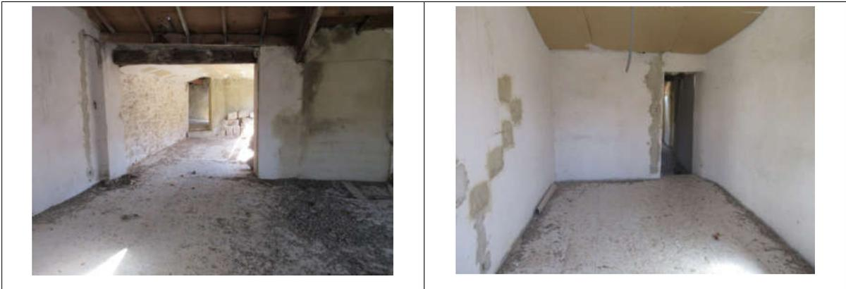
L'ensemble de l'immeuble est vétuste suite à une inoccupation prolongée et nécessite une rénovation complète, ainsi que d'importants travaux sur la structure du bâtiment comme l'étanchéité du toit terrasse, le renforcement des planchers et des fenêtres de l'escalier.
