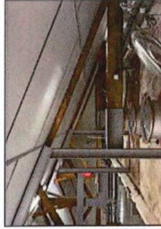
Appentis technique, Espace ouvert sur la façade Est du chai viticole // Charpente juste au-dessus des cuves de vinification, Création de mouvements dangereux pour les opérateurs
