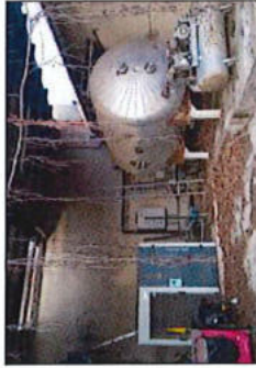
Appentis technique, Espace ouvert sur la façade Est du chai viticole // Charpente juste au-dessus des cuves de vinification, Création de mouvements dangereux pour les opérateurs
