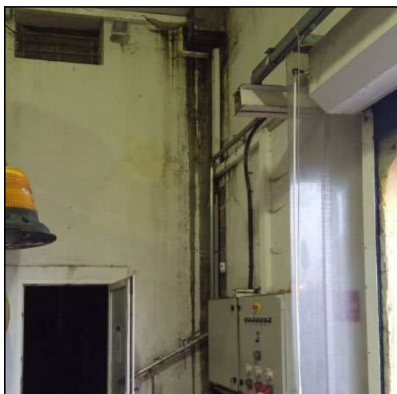
Chai viticole avec tâche d'humidité et d'infiltration d'eau depuis le plancher supérieur // Chai viticole avec tâche d'humidité et d'écoulement à proximité des réseaux électriques
