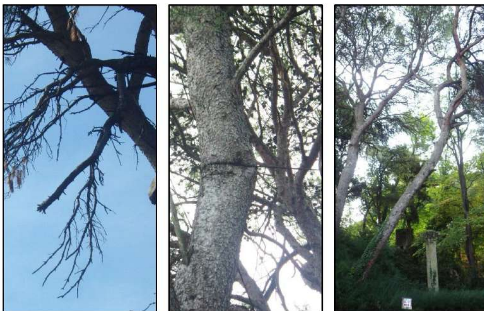
Bois mort / Strangulation par câble / Inclinaison excessive
