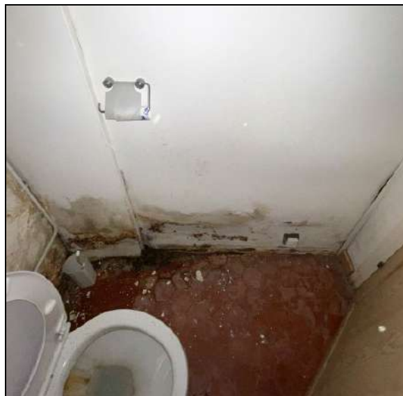
Espace de stockage du chai avec planches d'isolation de la toiture qui se détachent // Sanitaires du château avec des murs intérieurs contre la paroi rocheuse qui sont imbibés d'humidité
