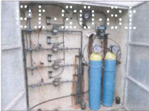
Le traitement de l'eau potable est assuré par un système de chloration par injection (asservi au débit) de chlore gazeux au niveau du captage de Russamp.
