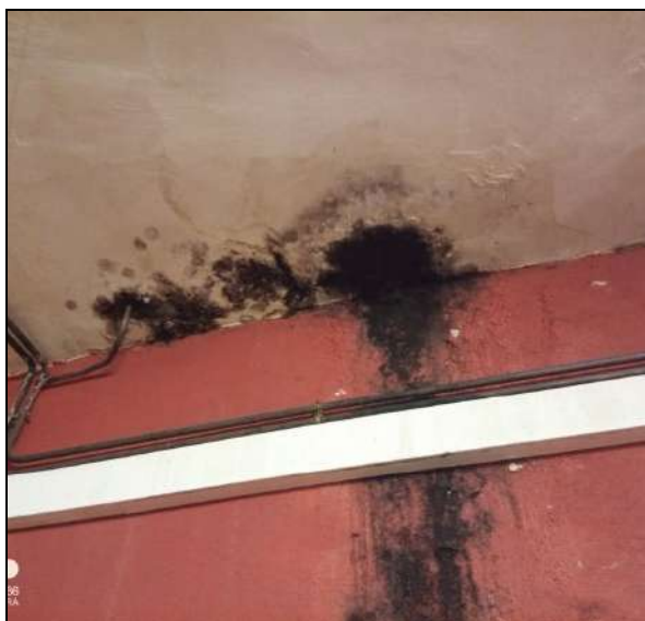
Chai viticole avec tâche d'humidité et d'infiltration d'eau depuis le plancher supérieur // Chai viticole avec tâche d'humidité et d'écoulement à proximité des réseaux électriques
