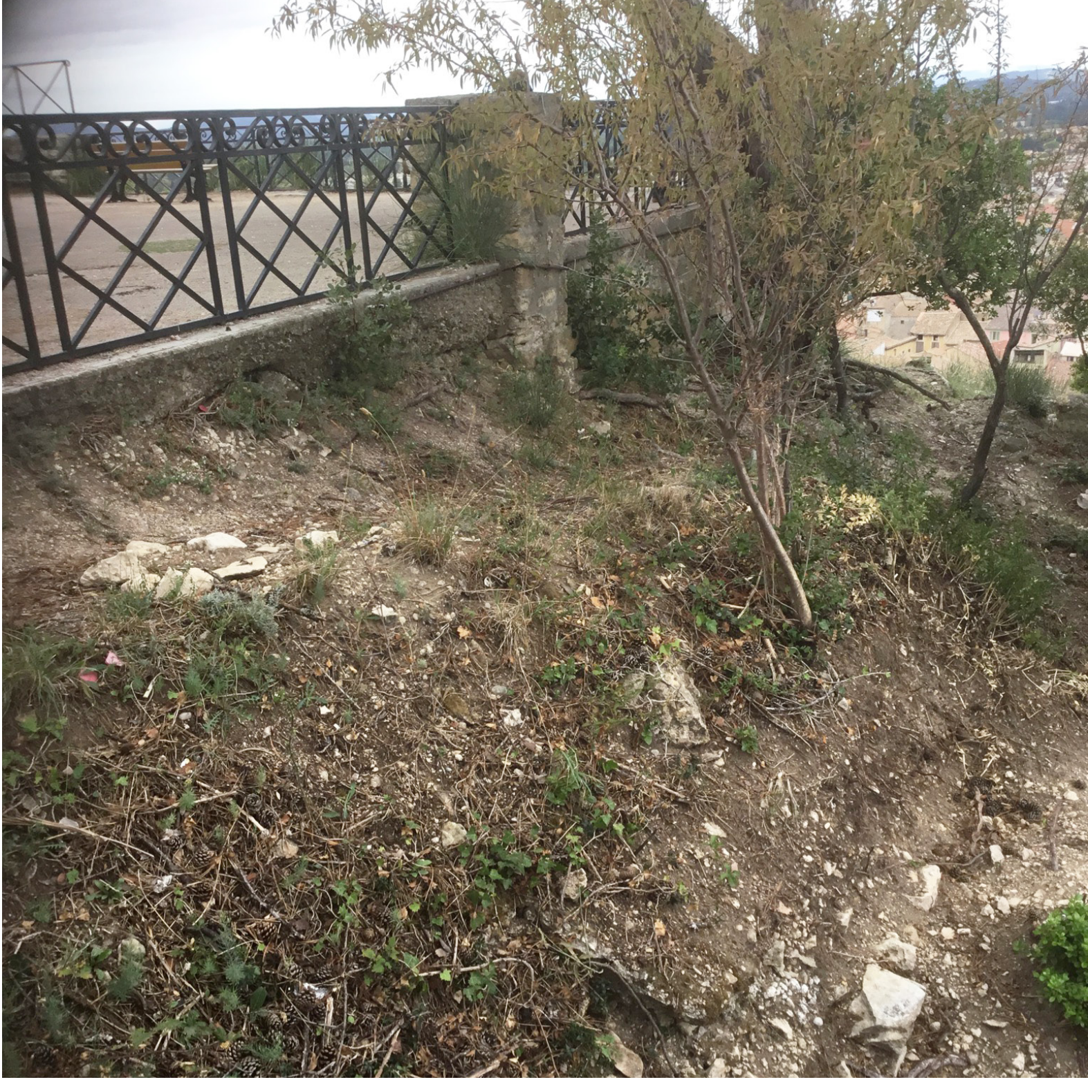
Courtine est avant intervention
