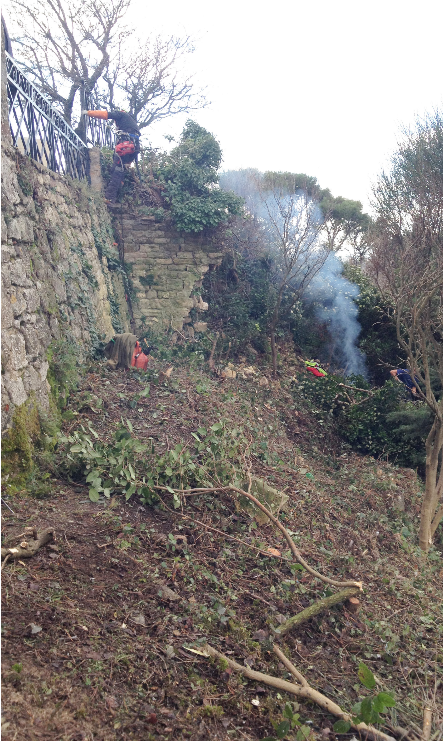
Courtine nord avant intervention (déroussaillage en 2016)
