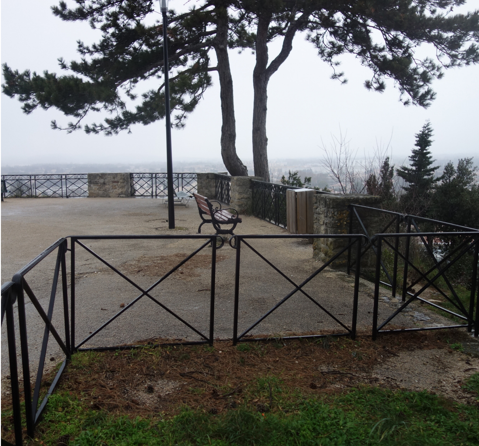
Terrasse du château avant intervention
