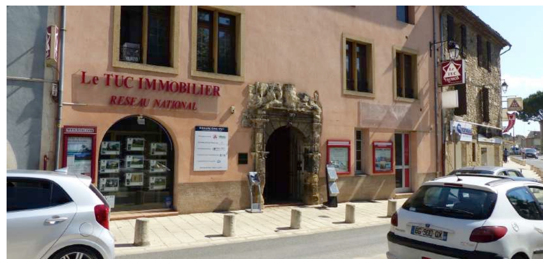
➤ Porte d'Hôtel particulier enfouie dans le traitement contemporain des baies et enseignes envahissantes
