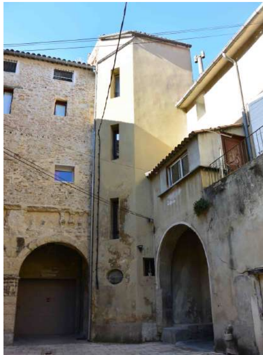
➤ Une des deux tours escaliers hexagonale présente dans la cour.
