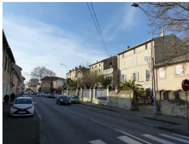
Maisons bourgeoises en retrait avec petit jardin au sud. La disposition des maisons à l'alignement exposé nord et jardinet exposé sud crée une rue asymétrique à fort intérêt urbain.
