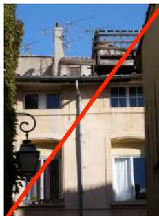
Terrasses posées sur la toiture : disposition interdite
