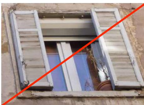
Menuiserie pvc et coffre de volet roulant en tableau Interdits
