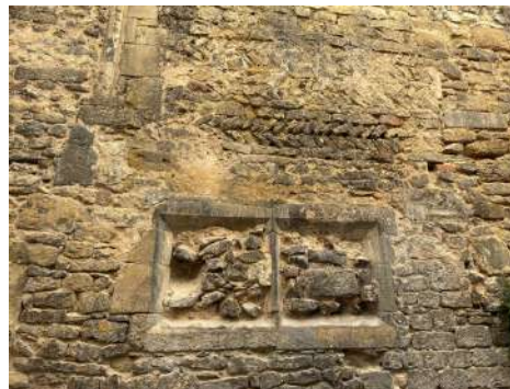
Baies à meneaux bouchées (horizontales) Appareil en épis (opus spicatum)
