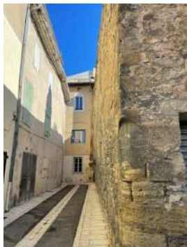
Mur de clôture du jardin de la demeure Saunier : Parement en petit appareil assis, réemploi médiéval et baie bouchée XIVe siècle
