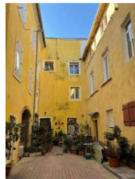
Façade intéressante : présence d'appuis et linteau en pierre de taille
