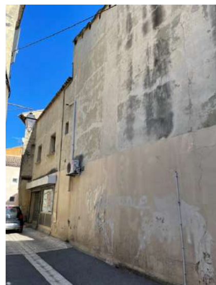
Rue des Avesnes
