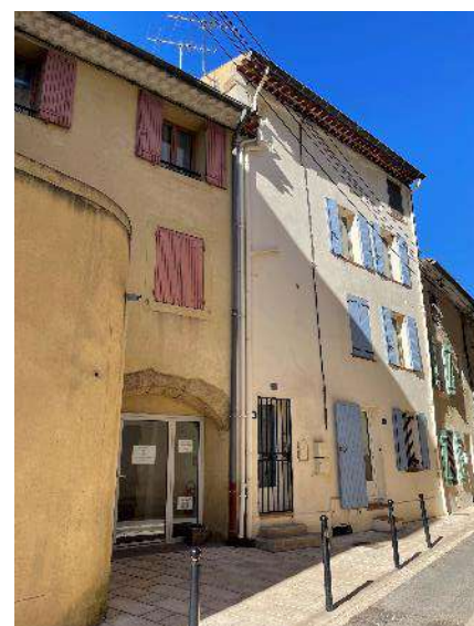
Rue de l'ancien Hôpital
