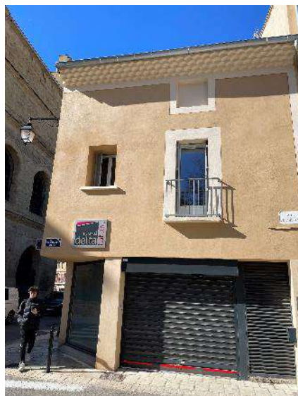
Rue de l'ancien Hôpital
