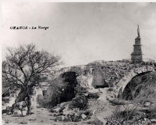
Une superbe image des fondations du château, cachées sous la statue de la Vierge. 1909.
