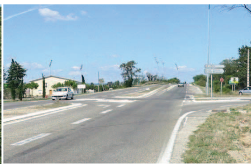
Pont sur l'autoroute A7
