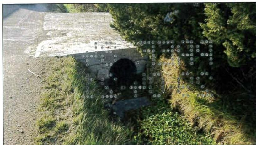
**Figure 11 : Exemple d'ouvrage de franchissement à proscrire**
